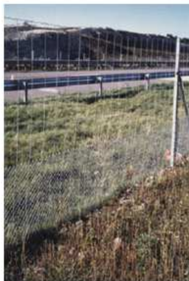
Fig. 81 : autoroute grillagée (source CETE de l'est)
